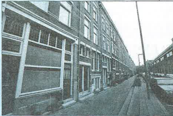
• Deze (oude) huizen werden opgeknapt, waarbij de fundering, de gevel en het dak onder handen werden genomen. FOTO: ROEL DIJKSTRA
